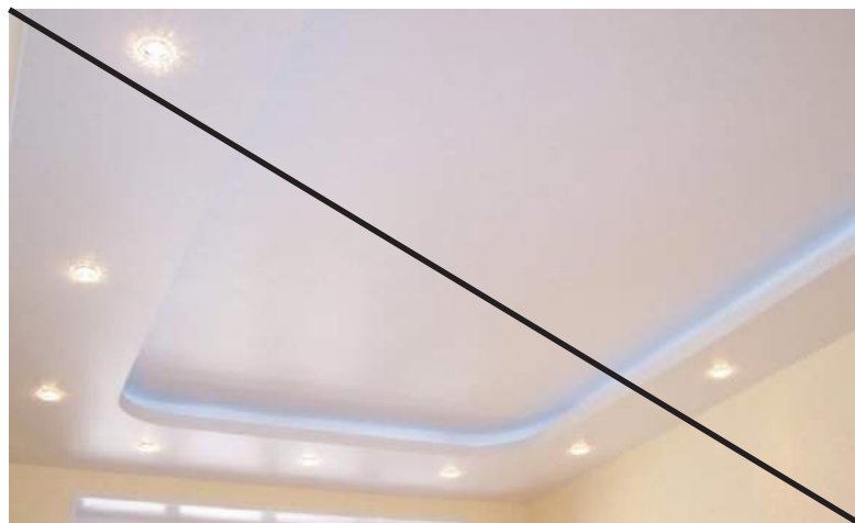
Плохо Многоуровневые гипсокартонные конструкции
